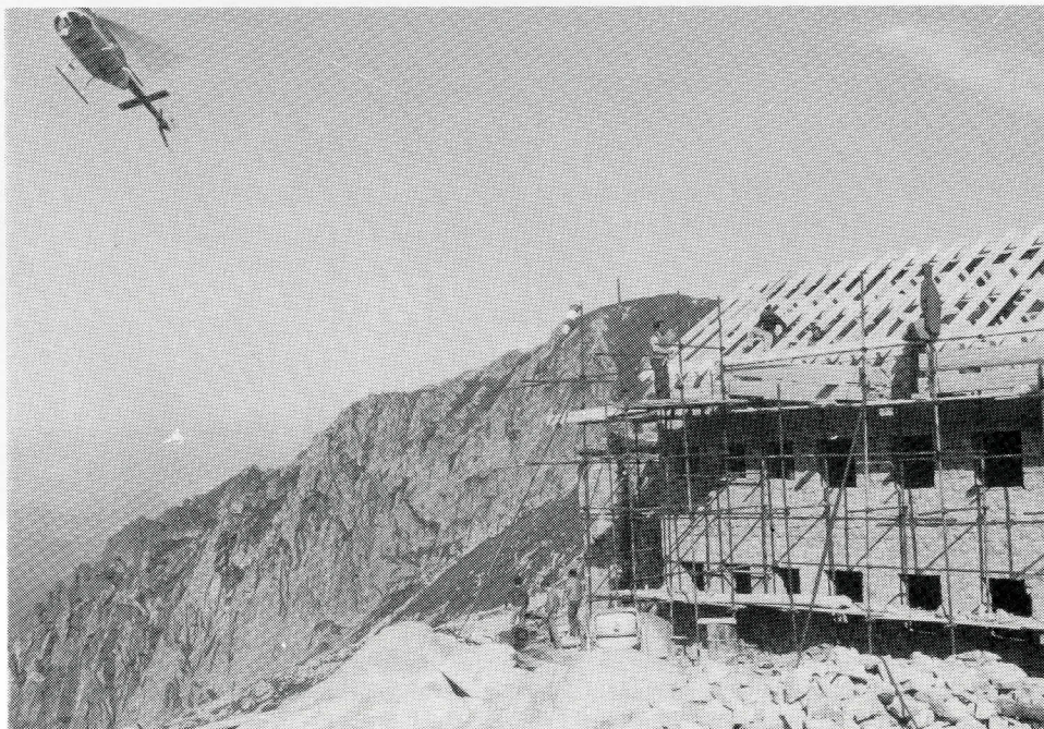
Rif. O. Brentari a Cima d'Asta, in costruzione
